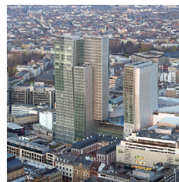
Beispiel: Palaisquartier Frankfurt, KSP Engel und Zimmermann Architekten
